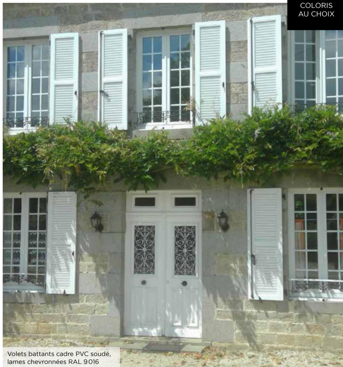
Volets battants cadre PVC soudé, lames chevronnées RAL 9016
